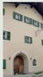
Der Brückwirt: In diesem Baujuwel arbeitet die Saalfeldner Kleidermacherin.
